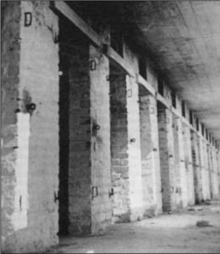
Innenansicht vom Bunker
