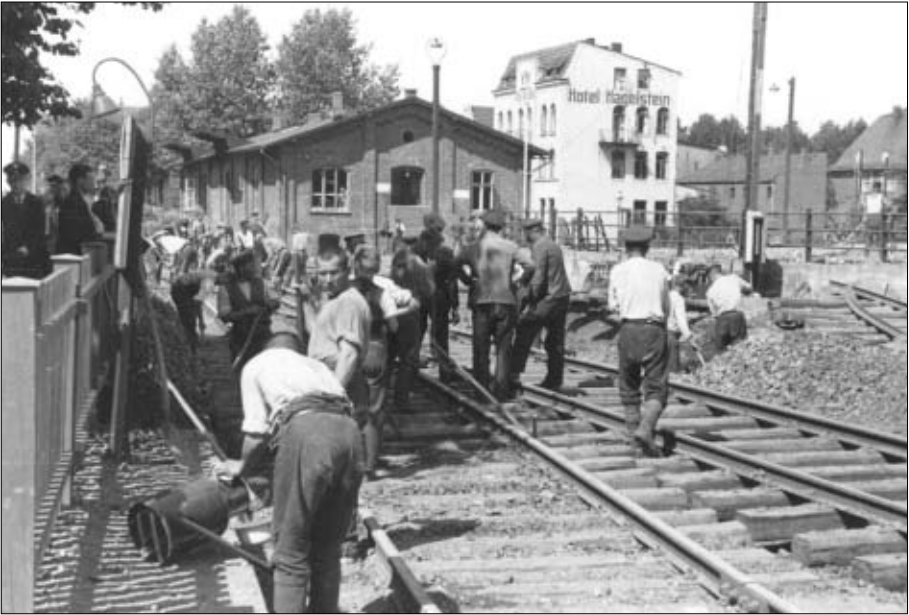
Reparatur der Schäden auf dem Heider Bahnhof nach dem Bomben- angriff am 23. Juli 1943
